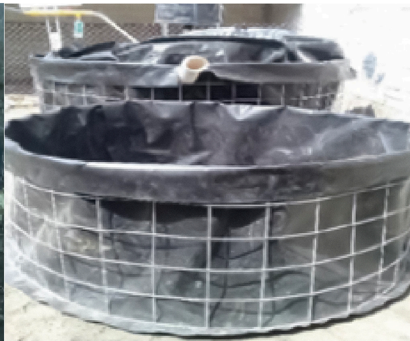
Figura 2. Montaje de la tina a la salida del reactor Fuente: Elaboración Propia
